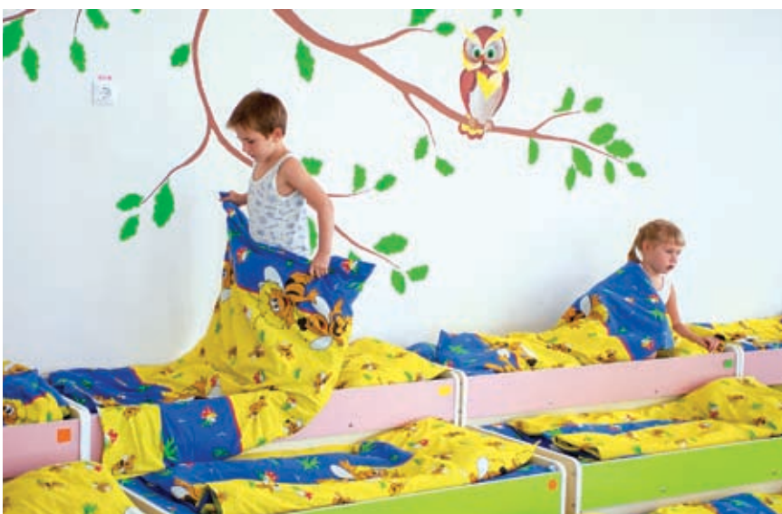
По краевой программе софинансирования в здании детского сада произведен капитальный ремонт двух групп. Теперь сюда смогут ходить на 50 ребят больше
